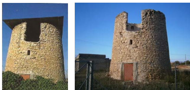
Figuras 3 y 4. Vista general del molino Buendía en 2007 con techo y en 2012 sin él
