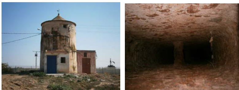
Figuras 23 y 24. Vista del molino de agua de Villa Antonia (izquierda) y su pozo en 2009 (derecha)
