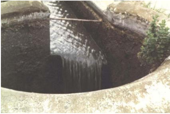
Entrada del agua al Cubo (Foto JMR)
