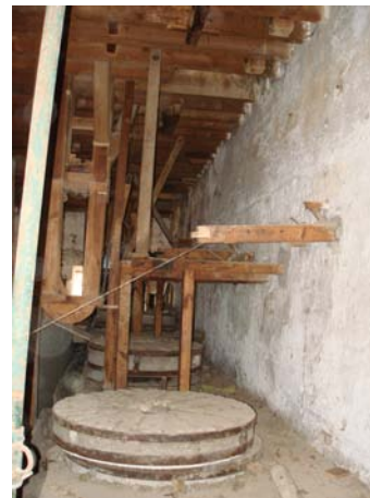
Molino del Marqués (Granada), durante su restauración (Foto JMR)
