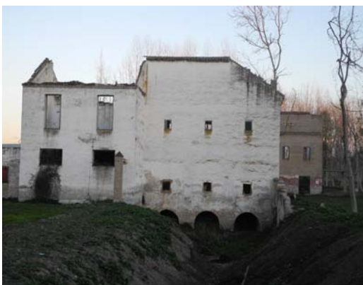
Molino de San Juan (reconvertido en fábrica de harinas) En la actualidad, se encuentra abandonado y afectado su entorno por la ejecución de las obras de la 2ª Circunvalación – Santa Fe, Granada (Foto JMR)
