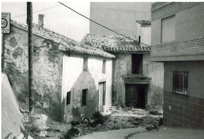
Figura 1. Estado del Molí de la Parra previo a su demolición (foto Museu Arqueològic de Lliria)
