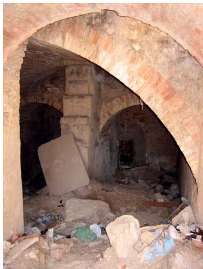
Figuras 3 y 4. Estado del interior de los cárcavos previo a la intervención (fotos del autor)
