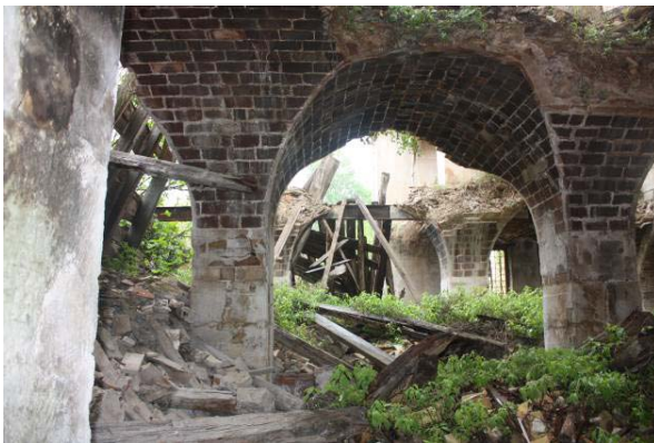
Ilustración 1. Bóvedas de ladrillo de uno de los molinos en ruina. Diana Sánchez, 2011
