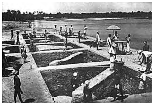
Ejemplo de excavación realizada por el método Wheeler 25
