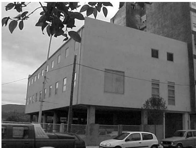
Novo edificio do arquivo municipal da Estrada (2003)
