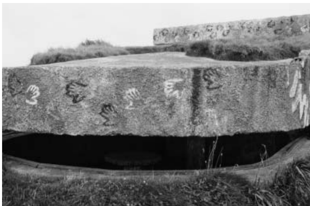
Bunker de la Guerra Civil. Sopelana. Vizcaya.
